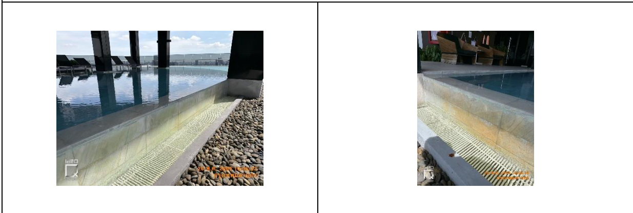
ภาพที่ 31 รางระบายน้ำรอบสระว่ายน้ำ
