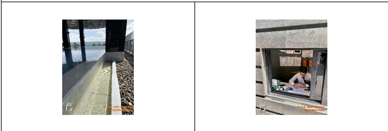
ภาพที่ 31 รางระบายน้ำรอบสระว่ายน้ำ(ต่อ)
